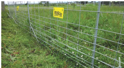
イノシシ対策② (ワイヤーメッシュ+しのび返し支柱システム)
