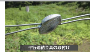
平行連結金具の取付け
