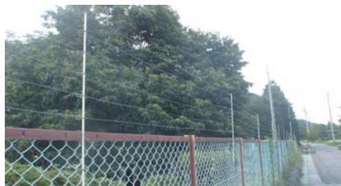
サル対策② (菱形金網+しのび返し支柱システム)
