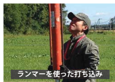
ランマーを使った打ち込み
